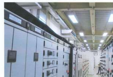
ตรวจสอบ Main Distribution Board
